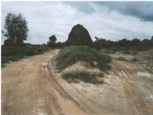
รูปที่ 8 แสดงคันกั้นน้ำดิน โดยที่ใช้เศษหินและดินปรับแต่งเป็นแนวกันน้ำบริเวณด้านตะวันออกทางเข้าโครงการฯ
